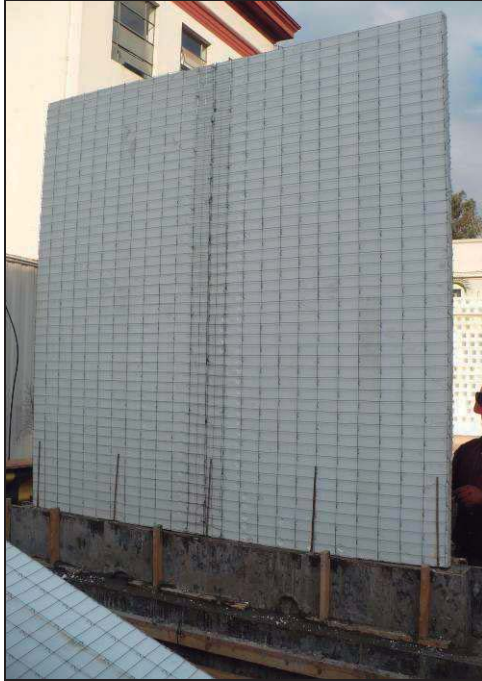
Foto 1. Estructura interna panel.
