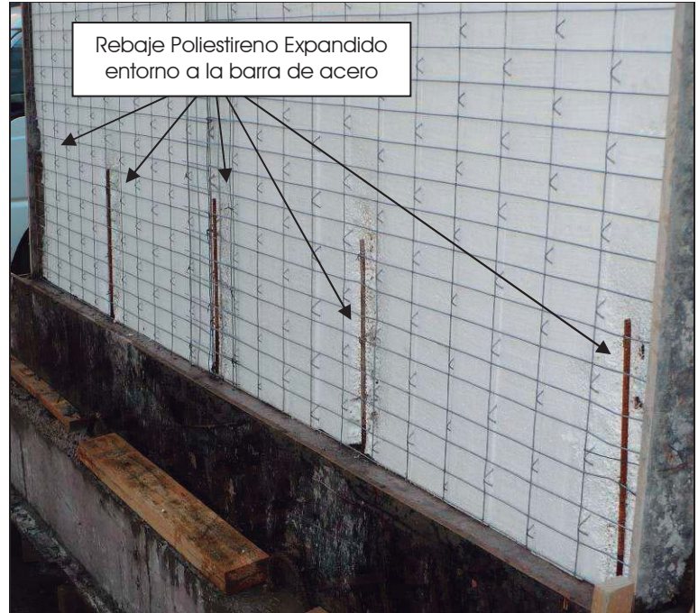
Foto 2. Zona de anclaje de panel.
