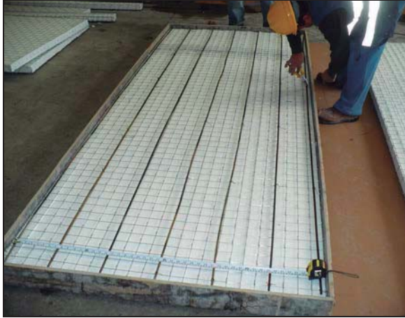
Foto 1. Barras de refuerzo inferior.
