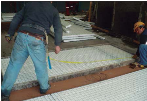
Foto 3. Refuerzo superior losa,
