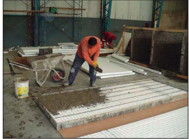
Foto 2. Colocación del revestimiento de mortero.
